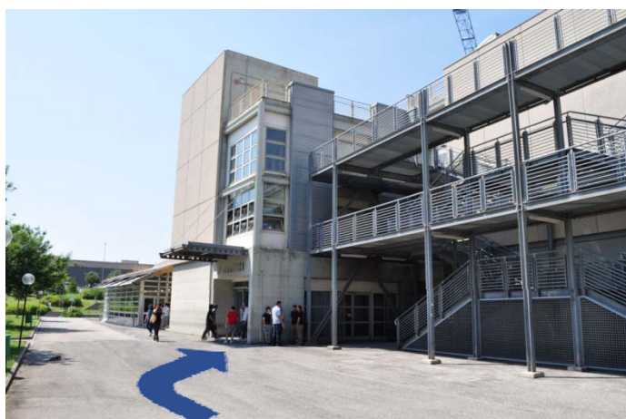
Foto 3 – Entrata dell'Edificio delle Aule
