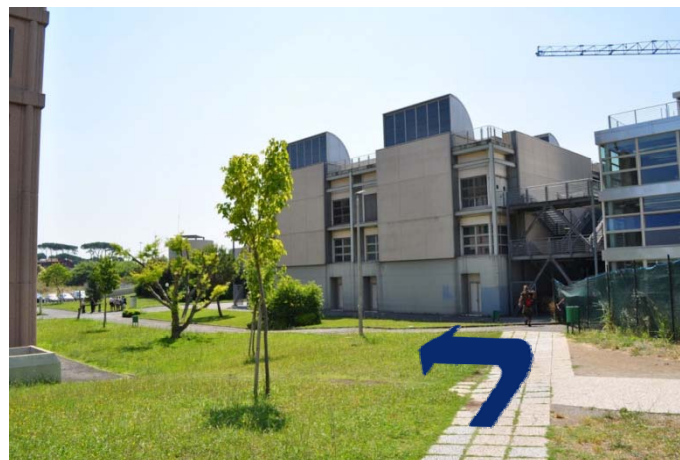
Foto 2 – Edificio delle Aule
